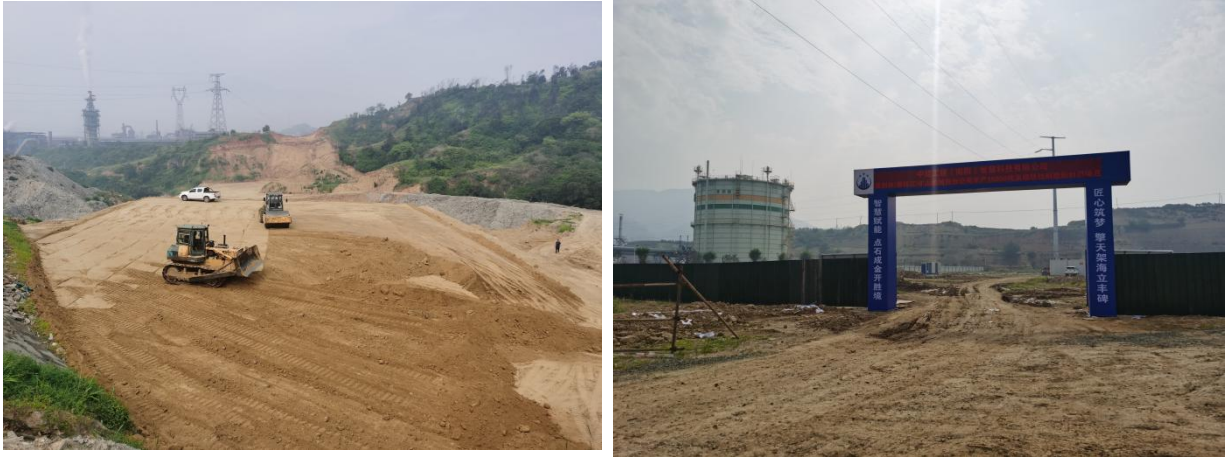
图 2.6-5 在建工程工地现状
