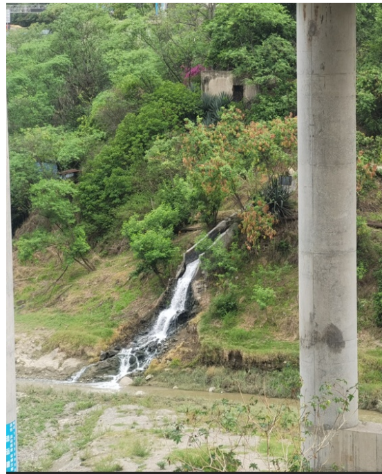
排洪沟出口位置
