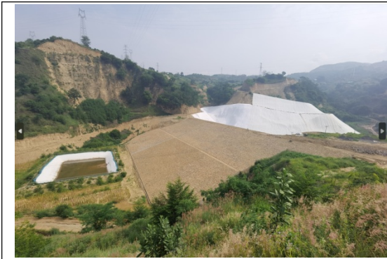
固废处理场初期坝现状
