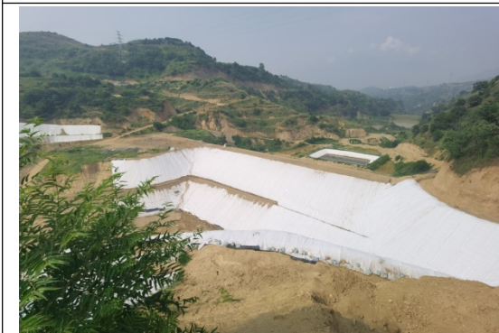
固废处理场初期坝及下游现状
