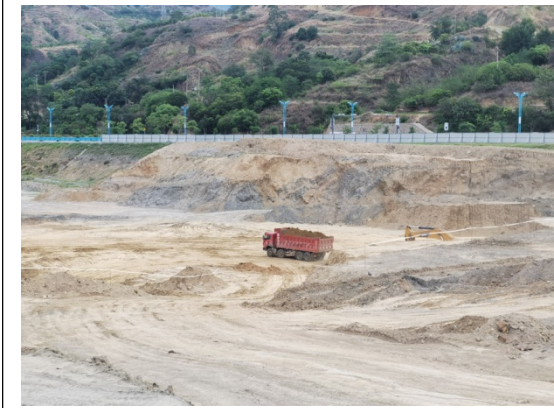
在建项目场地平整开挖
