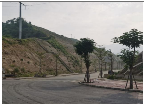
场内已建道路及边坡现状
