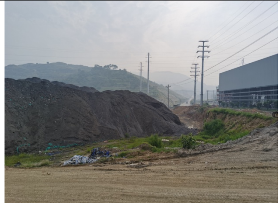
在建项目材料场内堆放
