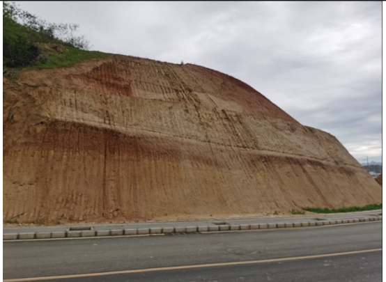
在建道路边坡
