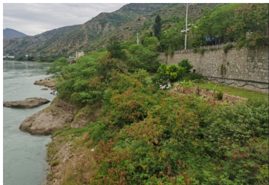
排洪沟出口位置
