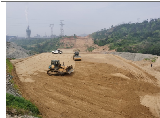
在建项目场地平整
