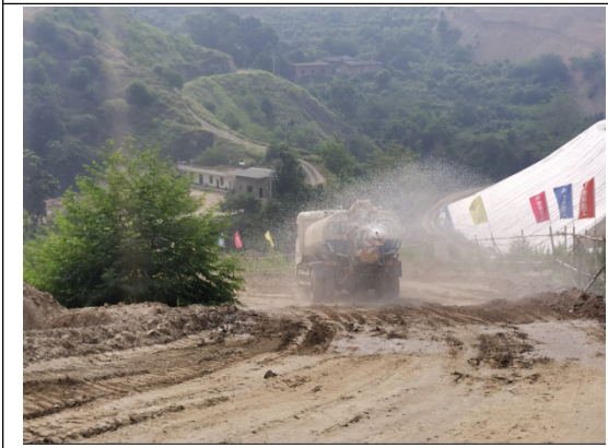
场内临时道路现状
