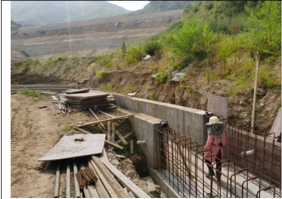
固废处理场右岸截洪沟在建
