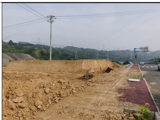
场内在建道路现状
