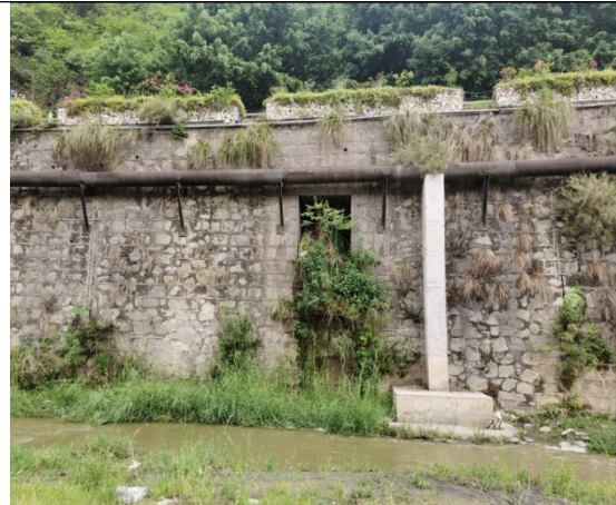
排洪沟出口位置
