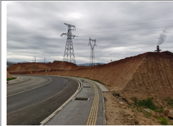
在建项目道路现状
