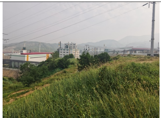
未建设区域现状
