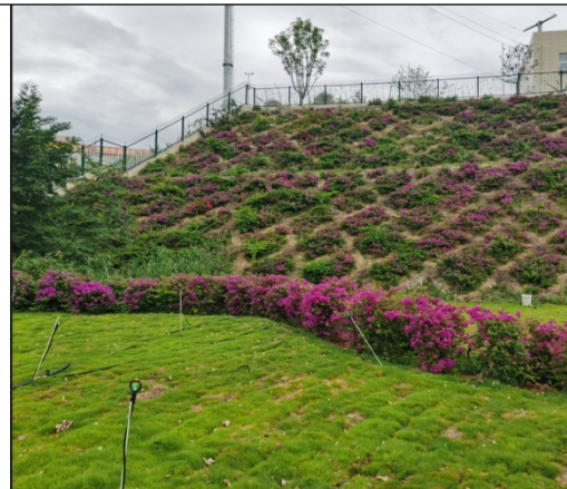
已建边坡绿化现状
