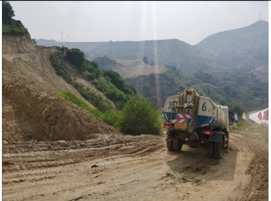
场内临时道路现状
