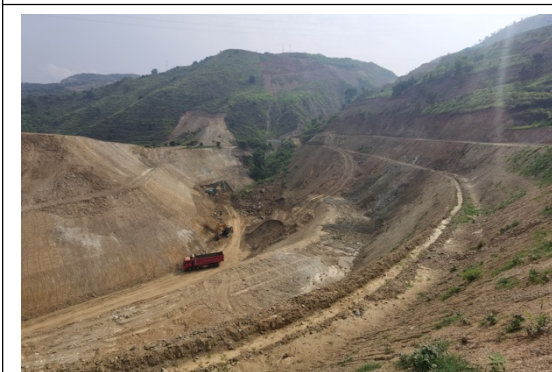
1930 平台表土堆场现状
