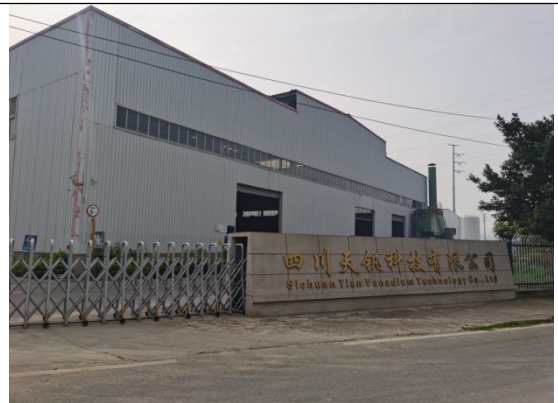
已建项目及场内道路现状
