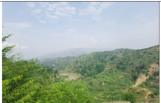
固废处理场下游二期坝位置
