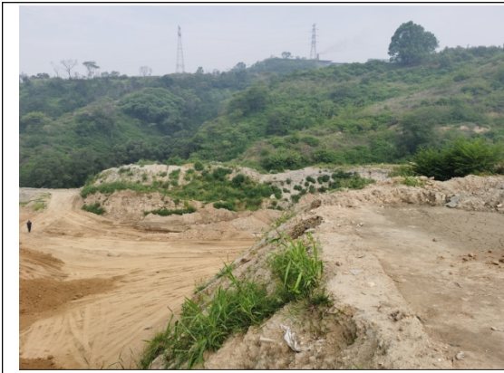
在建项目场地平整
