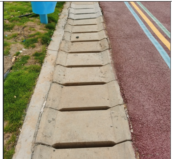
已建道路排水沟
