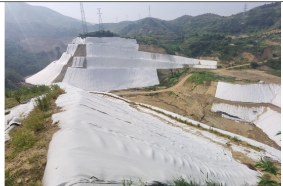
固废处理场初期坝及上游现状
