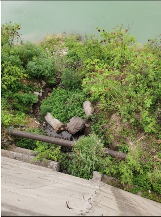
排洪沟出口位置
