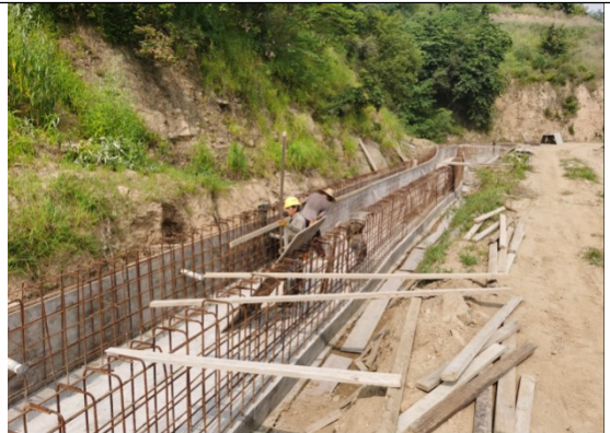
固废处理场右岸截洪沟在建
