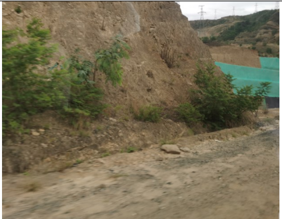
场内临时道路现状
