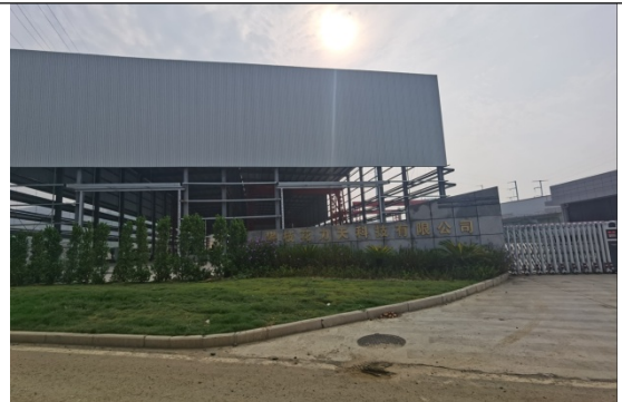
已建项目及场内道路现状
