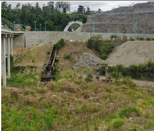
排洪沟出口位置
