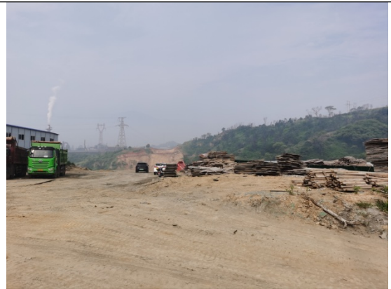
在建项目场地平整
