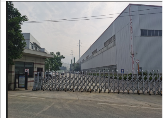
已建项目及场内道路现状
