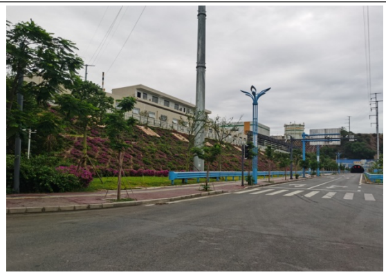
项目区内已建边坡绿化及道路现状
