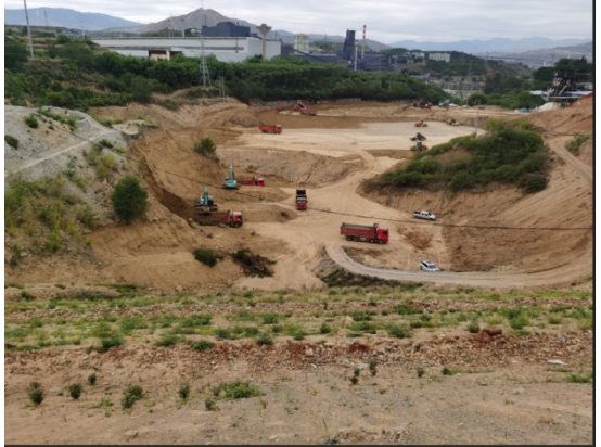
在建项目场地回填平整及回填边坡
