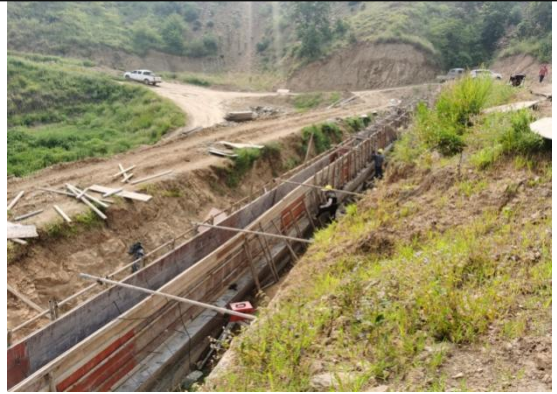
固废处理场右岸截洪沟在建
