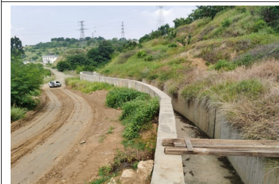
固废处理场右岸截洪沟
