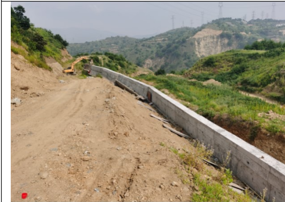
固废处理场右岸截洪沟在建
