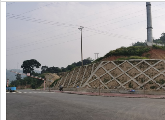
场内已建道路及边坡现状
