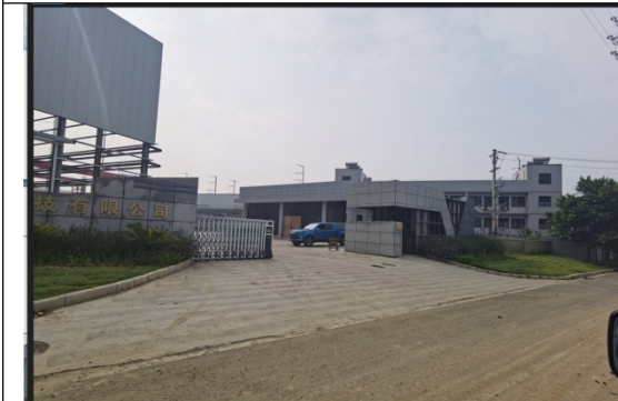
已建项目及场内道路现状
