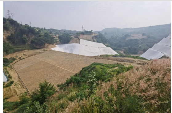
固废处理场初期坝现状
