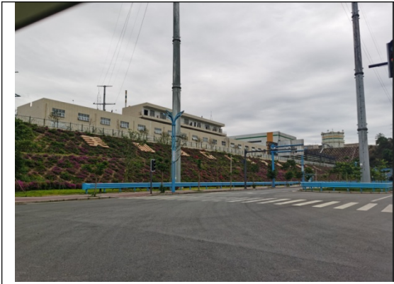
项目区内已建边坡绿化及道路现状
