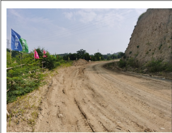
场内临时道路现状
