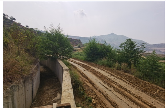
固废处理场右岸截洪沟
