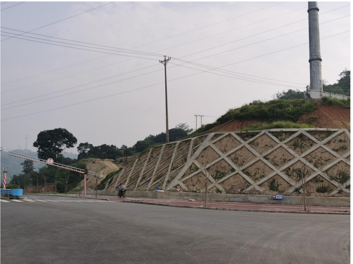
2.11.3.2 在建工程区水土流失现状
