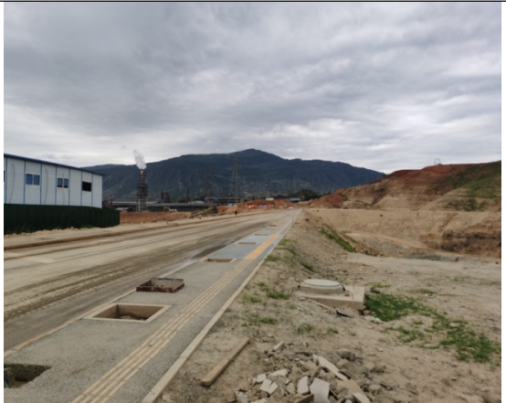
在建项目道路及回填路基现状
