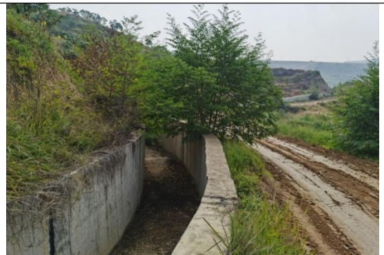
固废处理场右岸截洪沟
