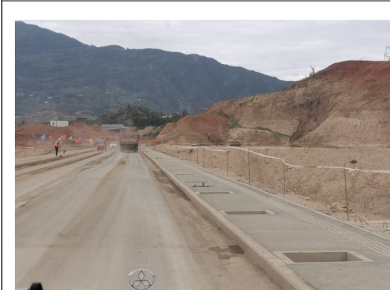
在建项目道路及回填路基现状
