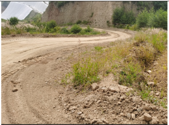
场内临时道路现状
