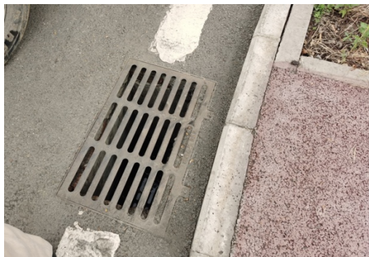
已建道路排水孔
