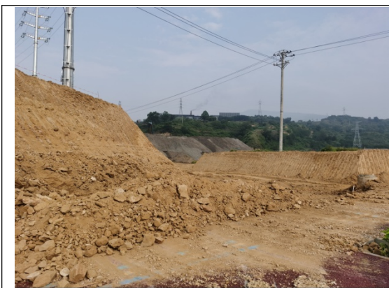
场内在建道路现状
