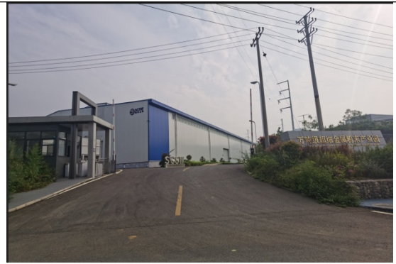
已建项目及场内道路现状
