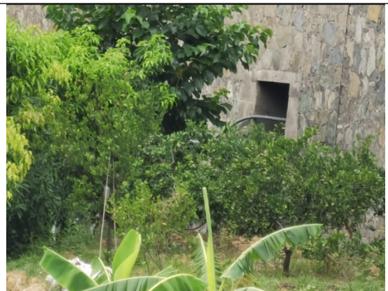
排洪沟出口位置
