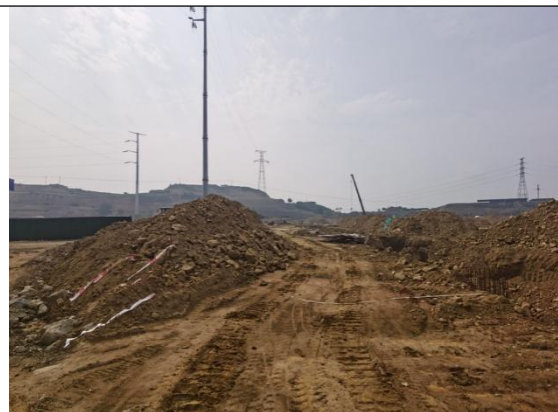
在建项目场地平整
