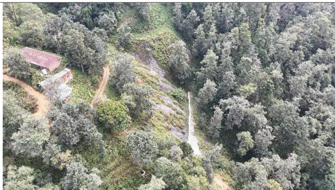
南翼矸石堆场现状
