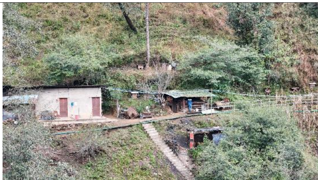
北翼风井安全出口附近的附属设施区
