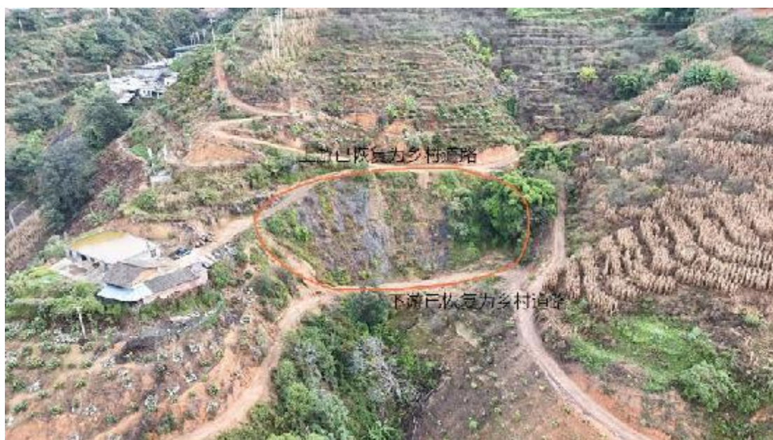
图 4.3-2 副平硐矸石堆场现状图
