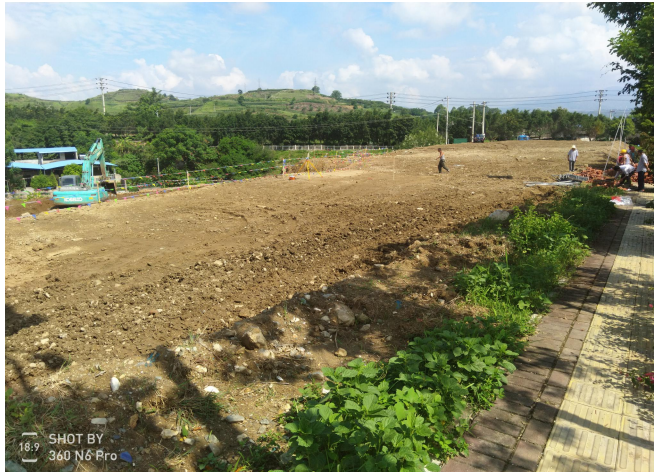
项目场平施工现场照片
