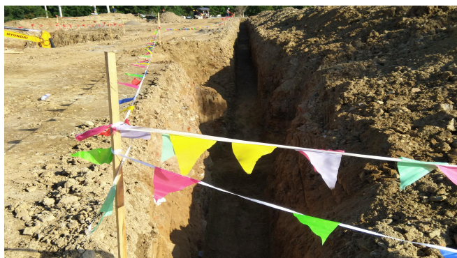
雨水管施工现场照片现场照片
