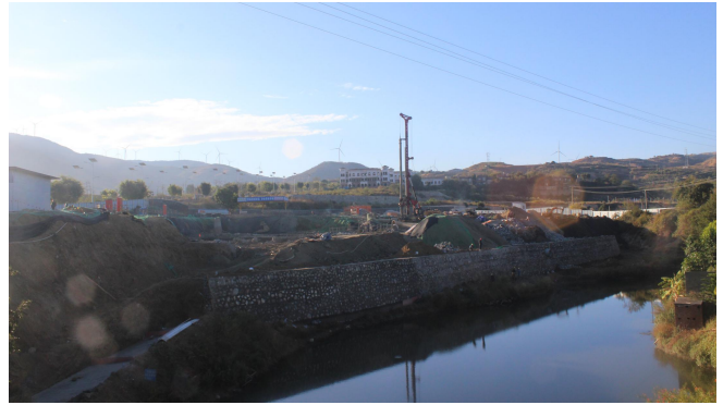
施工临时堆土现场照片
