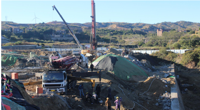
临时堆料现场照片
