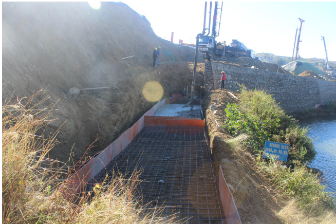
项目区西侧挡墙施工现场照片
