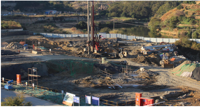
建筑物基础施工现场照片
