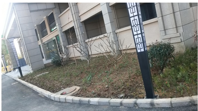
住宿楼绿化及雨水管现场照片
