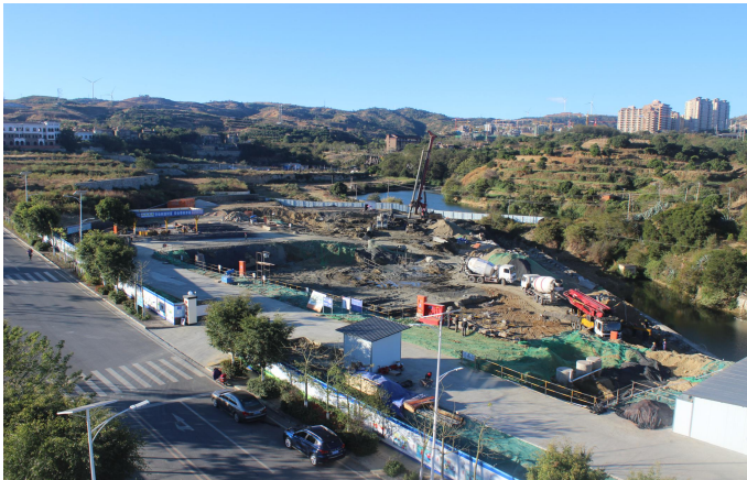
建构筑物基础施工现场照片
