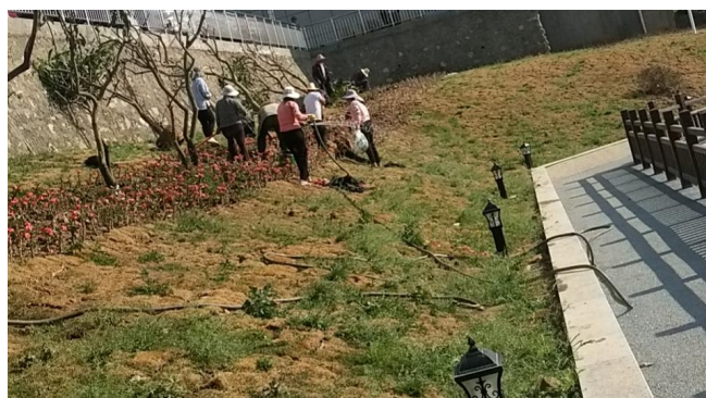
绿化工程施工现场照片
