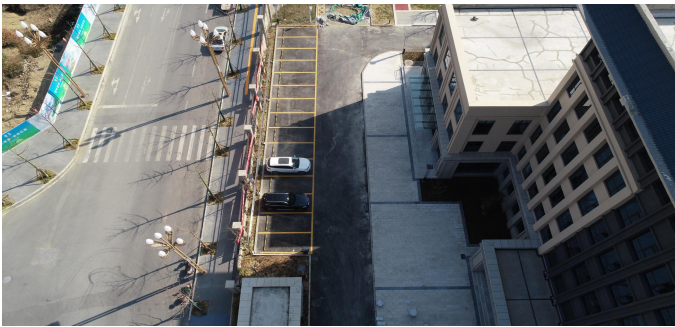
办公楼及接前广场现场照片
