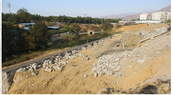
停车场西侧挡土墙施工现场照片
