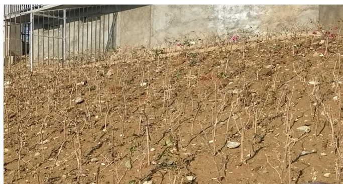
绿化工程施工现场照片
