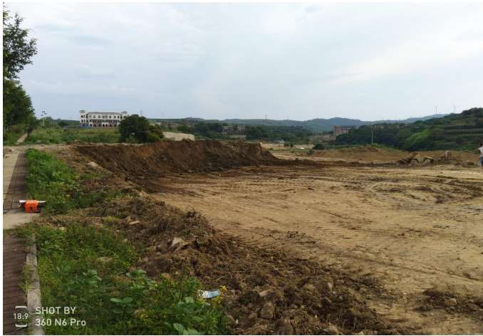
项目场平施工现场照片
