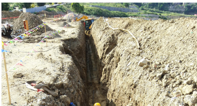
雨水管施工现场照片
